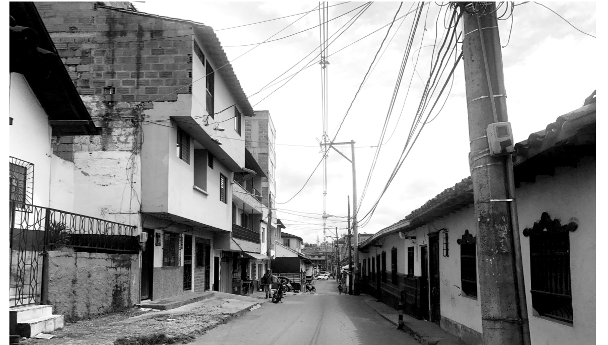
Estado actual de la calle
